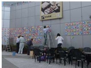
壁面への取り付け作業
